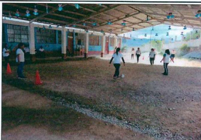
Foto 2: Losa de patio
